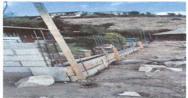
Foto 2: En la Foto se observa la circulación que será sustituida por el nuevo muro de 63 metros cuadrados.
